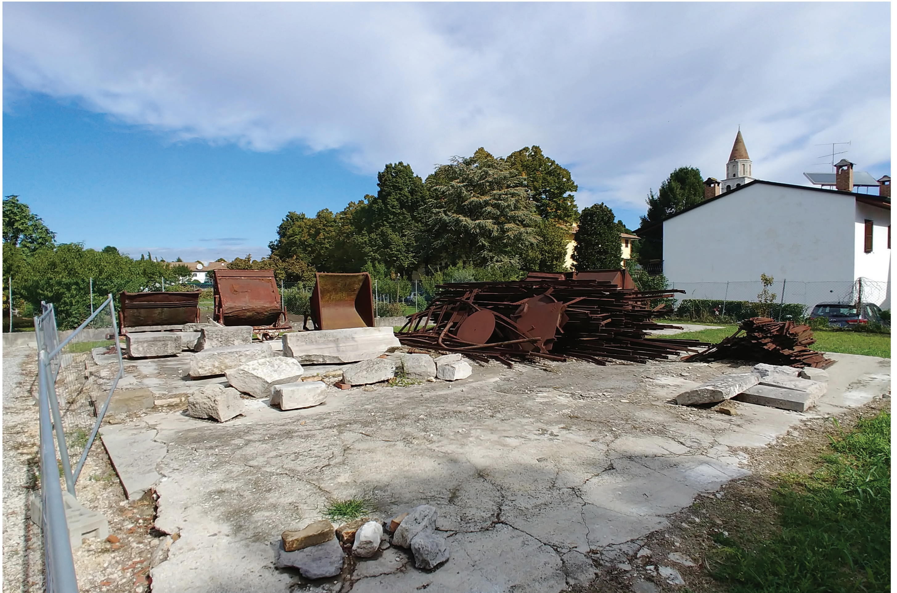
STATO DI FATTO AREA INGRESSO DA VIA ROMA: PARTICOLARE CARRELLI TRASPORTO TERRA DA SCAVO E PIATTAFORMA IN CLS
