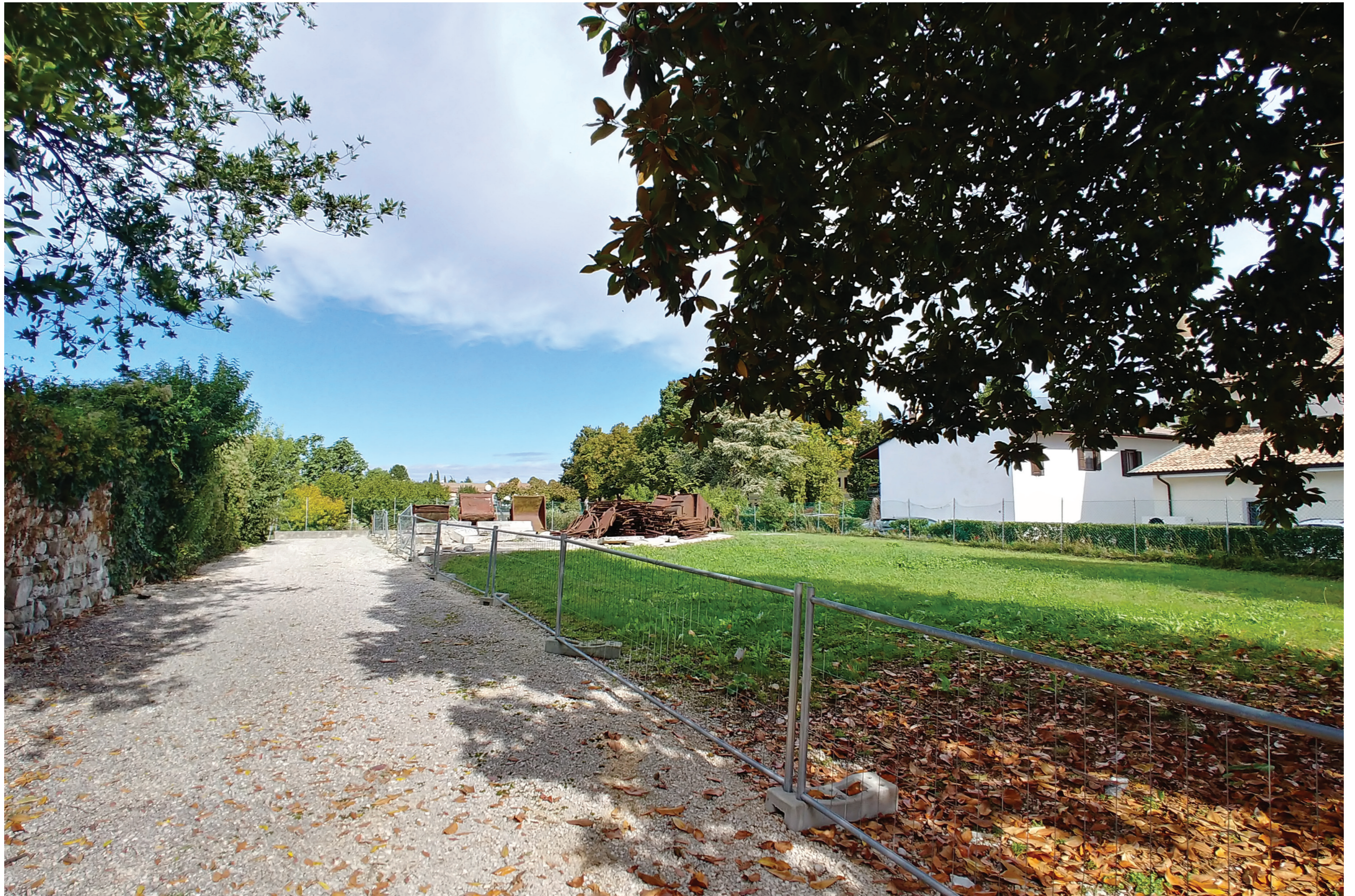
STATO DI FATTO AREA INGRESSO DA VIA ROMA: VISTA DA SUD (VIA ROMA)
