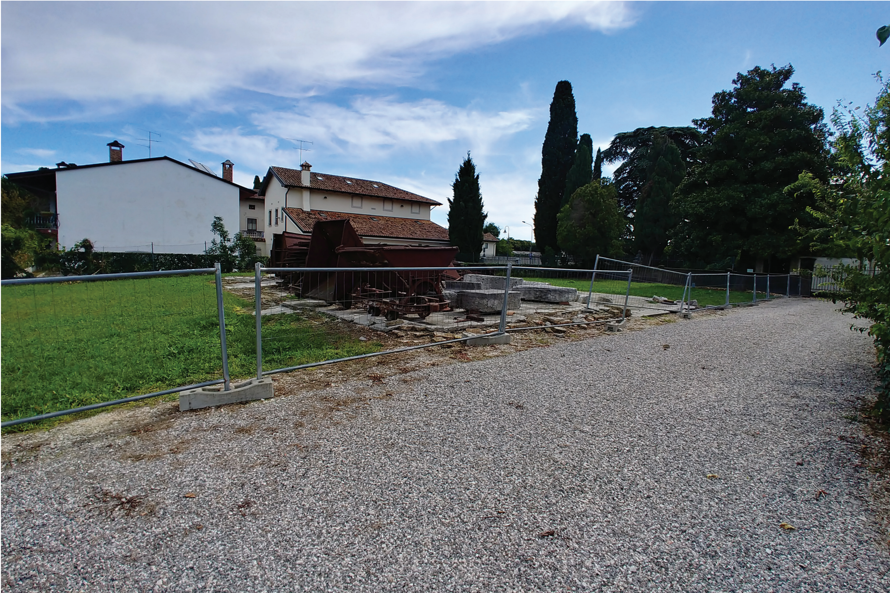
STATO DI FATTO AREA INGRESSO DA VIA ROMA: VISTA DA OVEST
