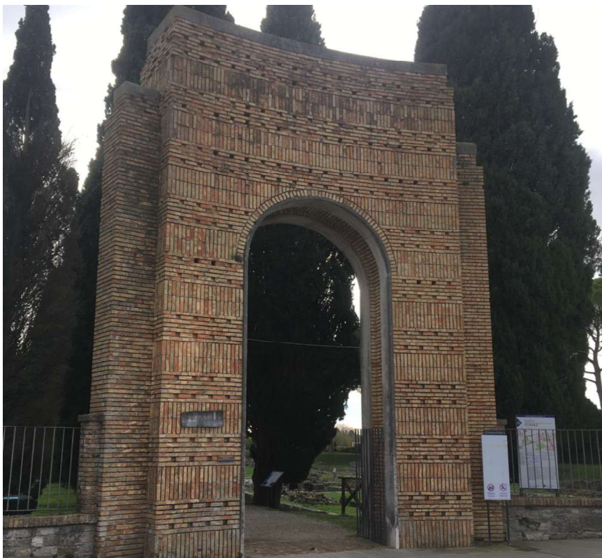
1) Portale monumentale d'ingresso
