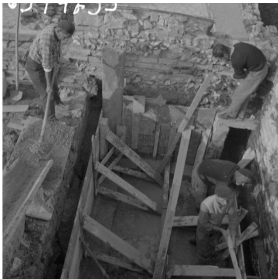
Fig. 85-87. 85. Neg. 4795-69. Getto della vasca sotto A.3-17. A destra la canna armata della condotta proveniente da nord, sotto A.2.16 (1964, da sud). 86. Neg. 3640-12. "Canale raccoglitore delle acque", sotto l'attuale passerella (1955, da ovest). Si notino le anfore italiche capovolte (Lamboglia ?) sul fondo; 87. Neg. 3671-28. Copertura del canale raccoglitore con passerella e vano pompe (1957, da est).
