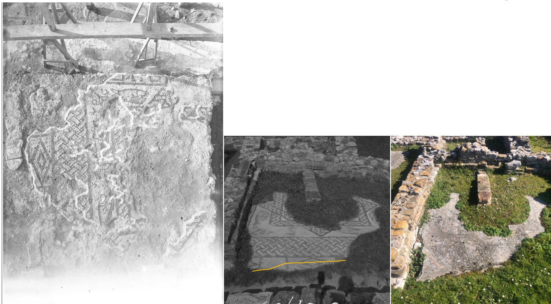
Figg. 33-35. 33. Neg. 3193 (1954). Fr. di lacerto musivo a cerchi di trecce P.6=568 in situ al momento dello scavo. Il nord è in alto, verso la fondazione della grande sala di rappresentanza; a sinistra il taglio di scavo orientale. 34. Neg. 5087 (1974). Lo stesso frammento negli anni Settanta, spostato nell'A.3.9 della casa sud. 35. Il frammento oggi (2022). Si nota la perdita di un tratto del mosaico con decorazione a losanga.
