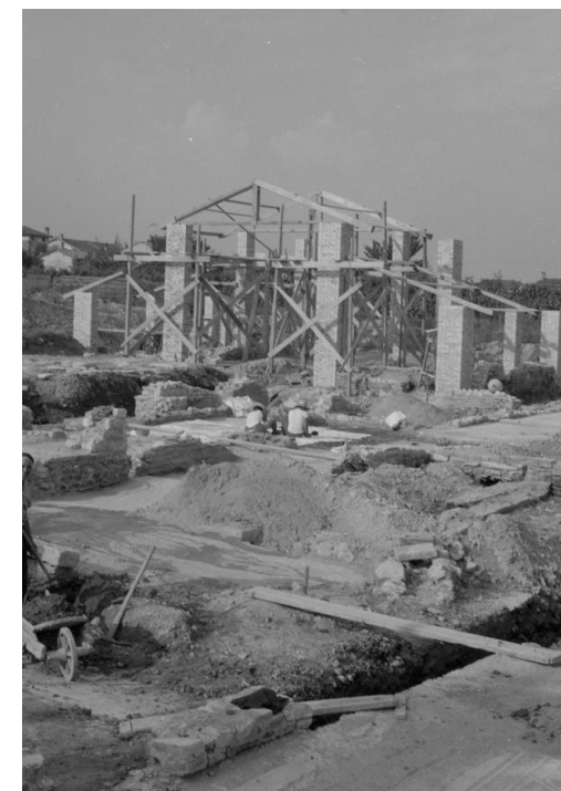
Figg. 59-60. 59. Neg. 3192 (1954). Aula A.3.2, con a sn. A.3.3, A.3.4, A.3.5 e a dx. A.3.6 e A.3.7. Si notano una fistula aquaria e a destra una canaletta(?). La colonnina sopra P.4 è rialzata al centro dell'aula absidata. 60. Neg. 3641-97 (1956; part.). La struttura di copertura, con i pilastri ormai eretti e poi rimossi.
