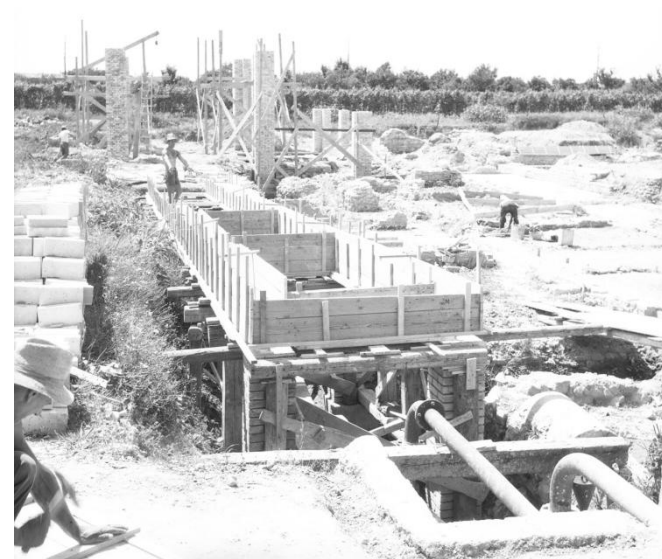
Fig. 85-87. 85. Neg. 4795-69. Getto della vasca sotto A.3-17. A destra la canna armata della condotta proveniente da nord, sotto A.2.16 (1964, da sud). 86. Neg. 3640-12. "Canale raccoglitore delle acque", sotto l'attuale passerella (1955, da ovest). Si notino le anfore italiche capovolte (Lamboglia ?) sul fondo; 87. Neg. 3671-28. Copertura del canale raccoglitore con passerella e vano pompe (1957, da est).
