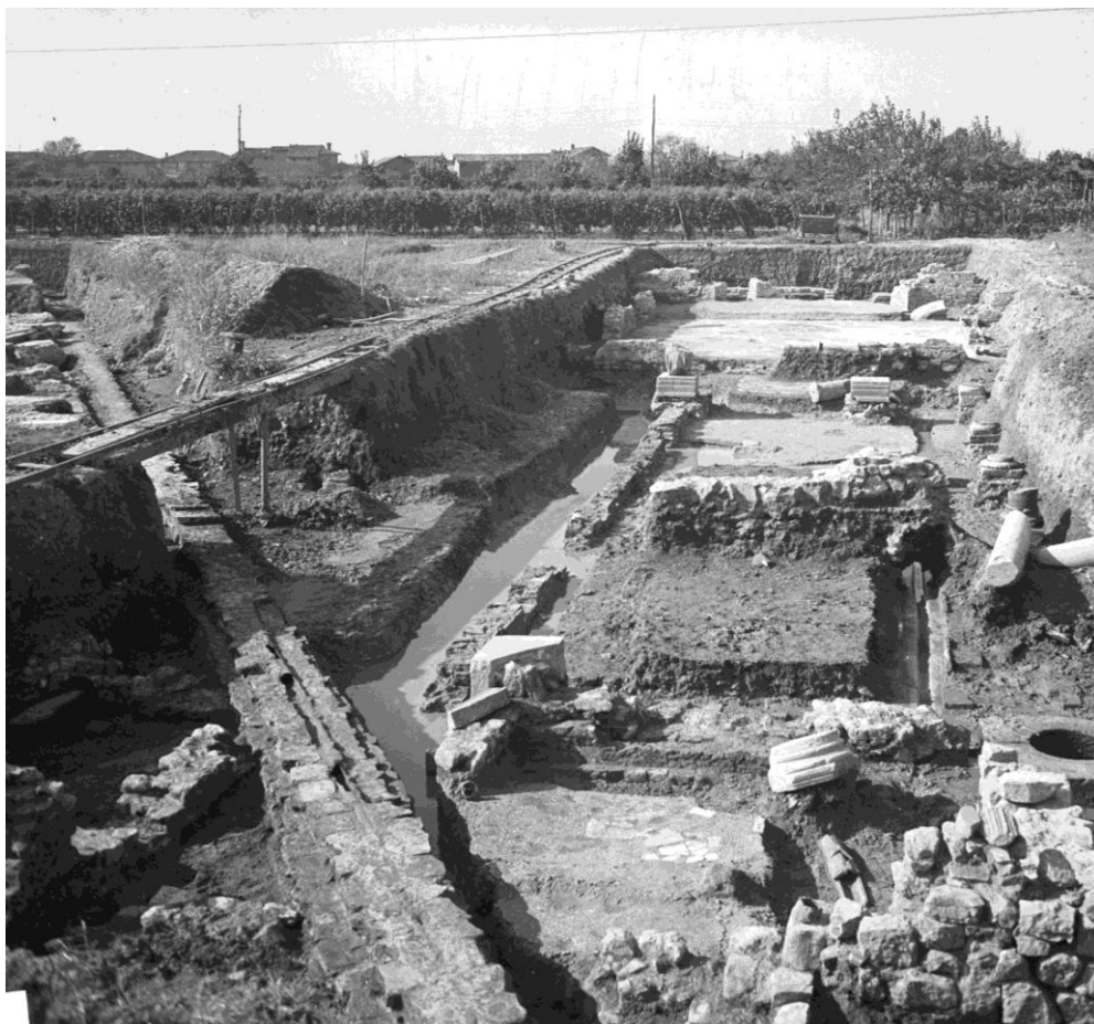
Figg. 61-62. 61. Neg. 3255 (1954). Acquedotto teresiano (a destra), ripreso da nord-est: taglia tutte le strutture antiche documentate nella zona. Particolare della tubatura fittile e del rinfianco in laterizi.
