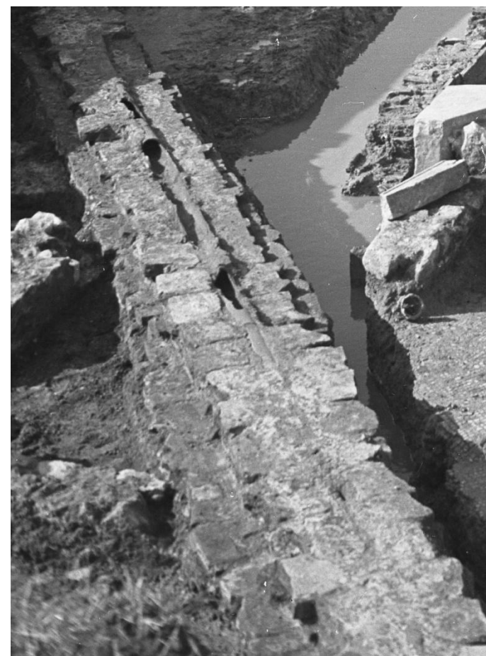
Figg. 61-62. 61. Neg. 3255 (1954). Acquedotto teresiano (a destra), ripreso da nord-est: taglia tutte le strutture antiche documentate nella zona. Particolare della tubatura fittile e del rinfianco in laterizi.
