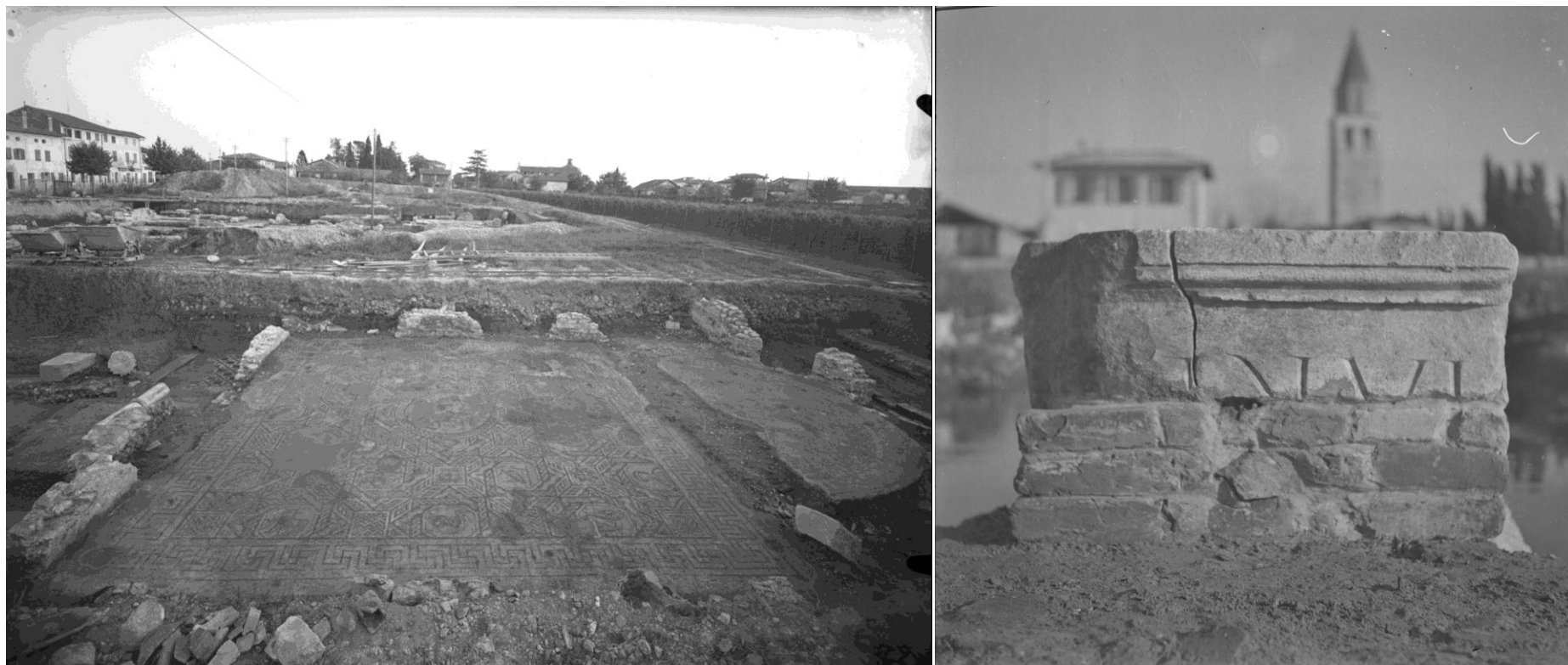
Fig. 11-12. 11. Neg. 3268 (1954), l'aula del Buon Pastore ripresa da nord; 12. Neg. 3480 (1954), blocco iscritto monumentale nella fondazione del colonnato.
