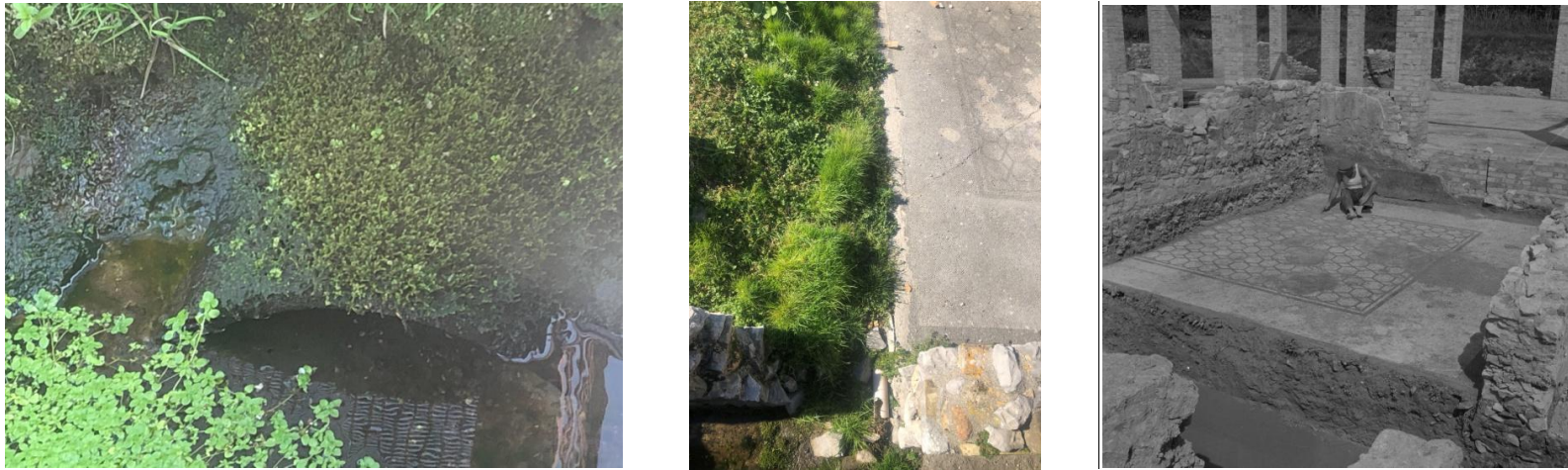
Fig. 73-75. 73. Tubo in cls da zona del Buon Pastore verso sud (2022); 74. Tubatura in plastica di canale secondario a margine del vano A.1.10 (2022); 75. Neg. 3676-110. Scavo a margine dell'A.2.10 (1957), con sullo sfondo aula del Buon Pastore in costruzione.
