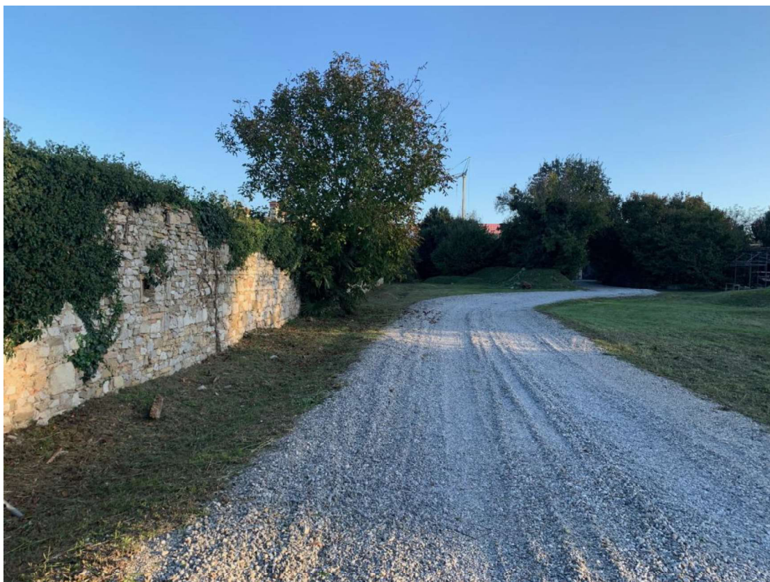
Punto di vista 9_ Il muro perimetrale in pietrame e la strada provvisoria di cantiere che attraversa la braida
