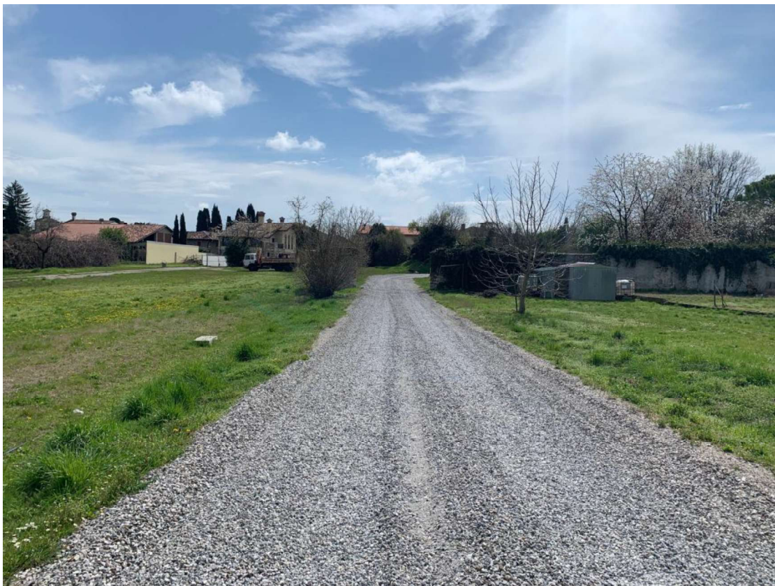
Punto di vista 11_ ambito di progetto esterno all'area di pertinenza del Palazzo, con strada provvisoria di cantiere e porzione a prato. Sullo sfondo l'accesso alla braida
