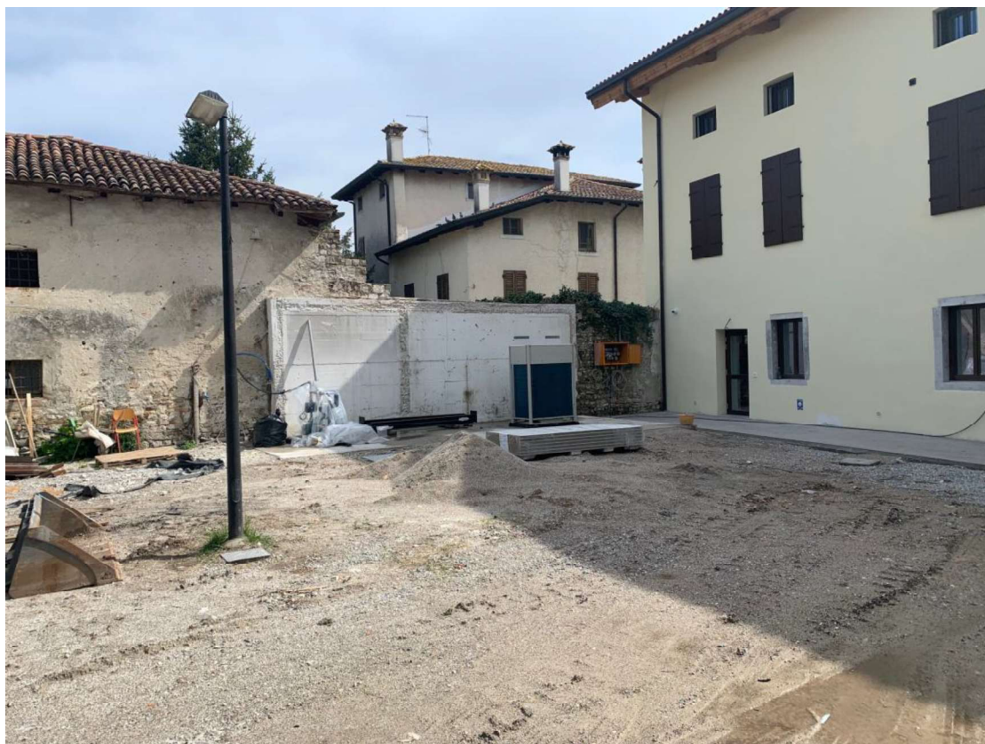
Punto di vista 1_ Il cortile e l'area che ospita l'impianto tecnico, sulla destra il palazzo Brunner.
