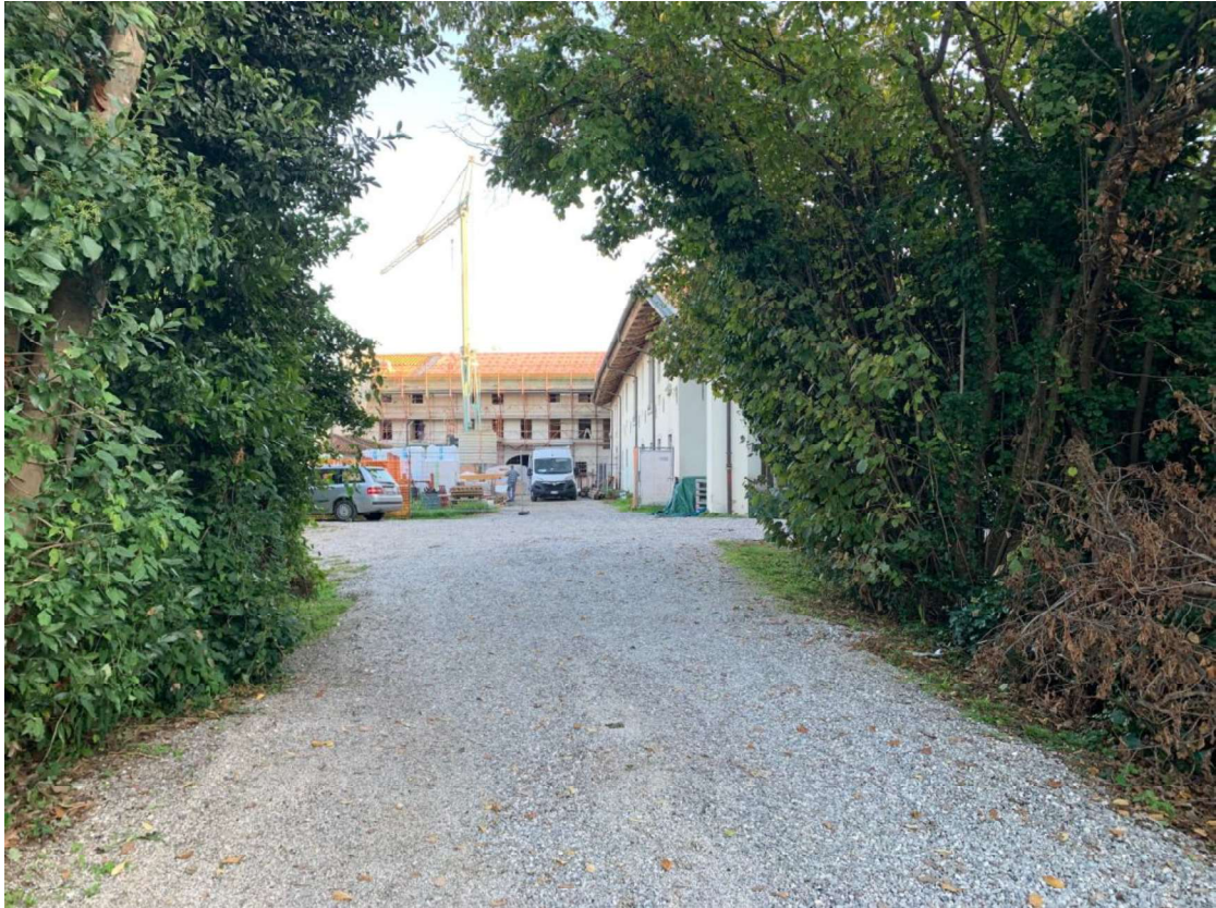
Punto di vista 5_ La strada provvisoria di cantiere che porta al cortile
