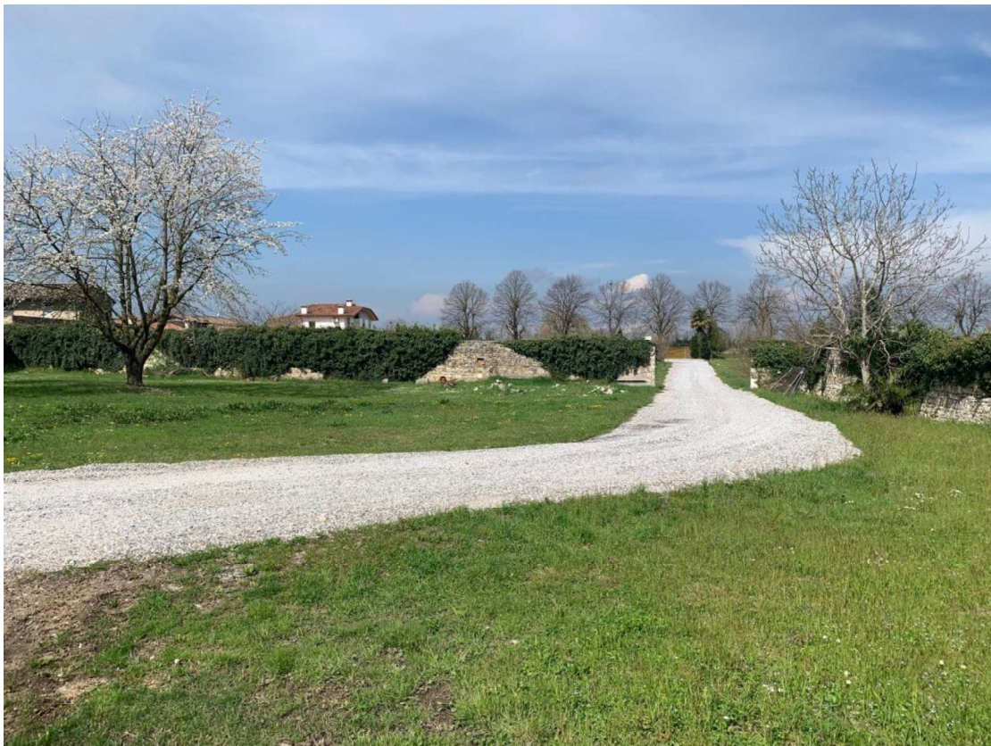
Punto di vista 8_ La braida cinta dal muro perimetrale, in parte coperto dalla vegetazione, e attraversata dalla strada provvisoria di cantiere.
