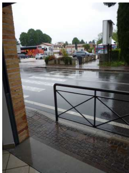
Fig.11 Marciapiede con restringimento per presenza parapetto.
