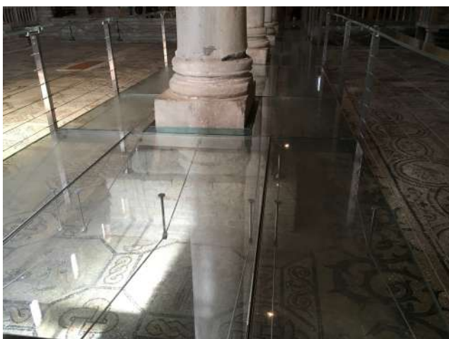
Fig.10 Passerella in vetro con parapetti.
