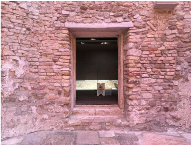
Fig.6 Vista interna dell'ingresso alla Südhalle.
