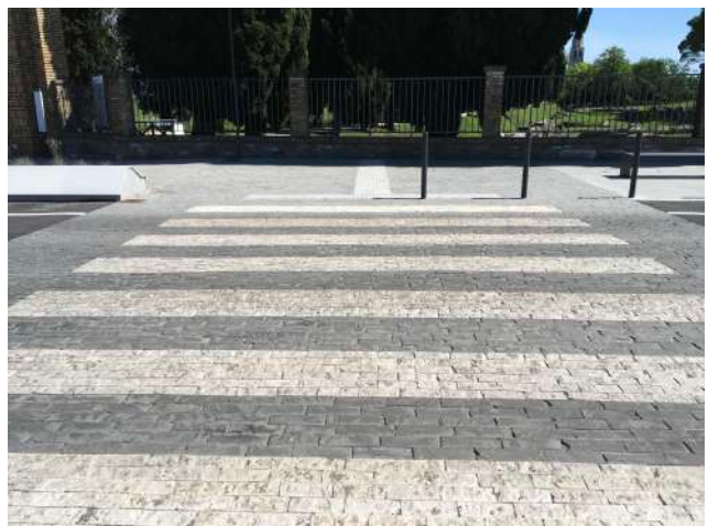
Fig.5 Attraversamento stradale con segnale tattilo-plantare loges.
