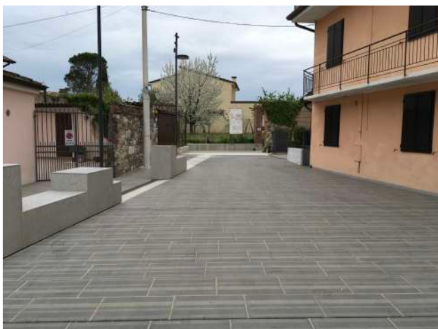
Fig.2 Piazzale pavimentato non accessibile al pubblico.
