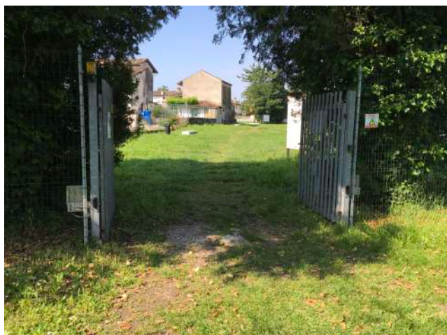
Fig.2 Vista esterna dell'ingresso Est.
