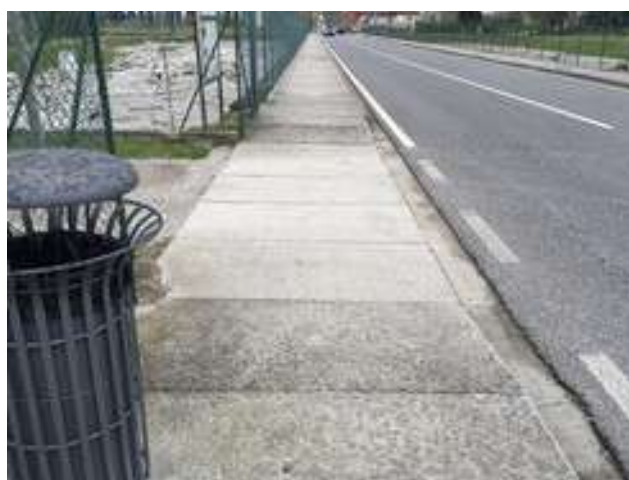
Fig.11 Marciapiede dell'area Ovest del Foro.
