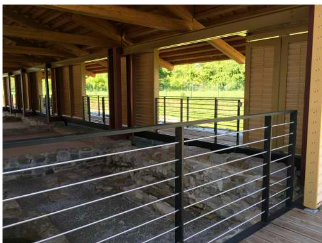
Fig.8 Struttura di copertura.
