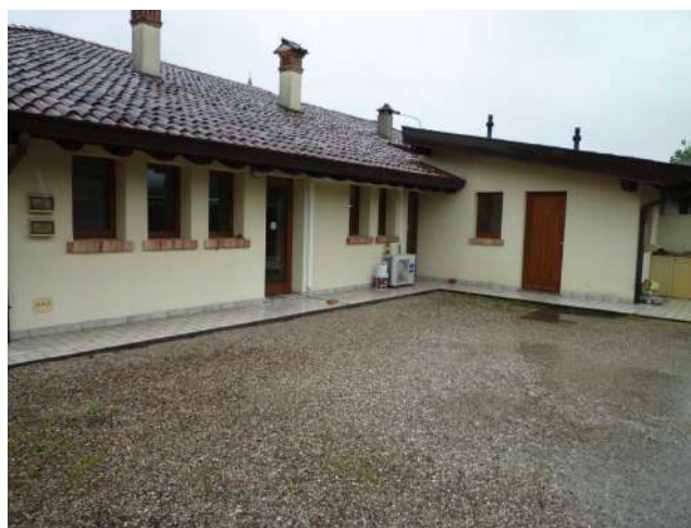
Fig.6 Corte interna ed accesso retrostante.
