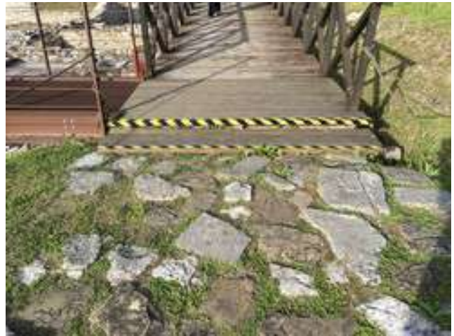
Fig.7 Tratto conclusivo della passerella in legno con segnalazione di sicurezza.
