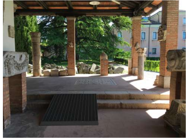
Fig.27 Percorso del lapidario con rampa metallica.
