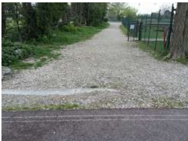
Fig. 6 Percorso in ghiaia di collegamento tra pista ciclabile e marciapiede.
