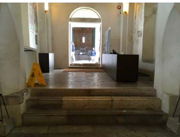
Fig.8 Vista interna dell'ingresso principale al Battistero e dei gradini segnalati.
