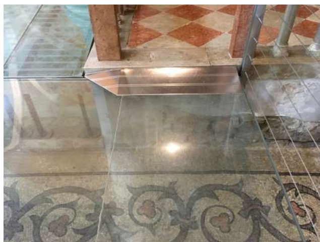
Fig.11 Scivolo metallico di raccordo tra i livelli.
