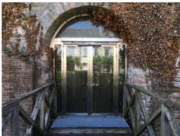
Fig.7 Porta di collegamento col percorso interno.
