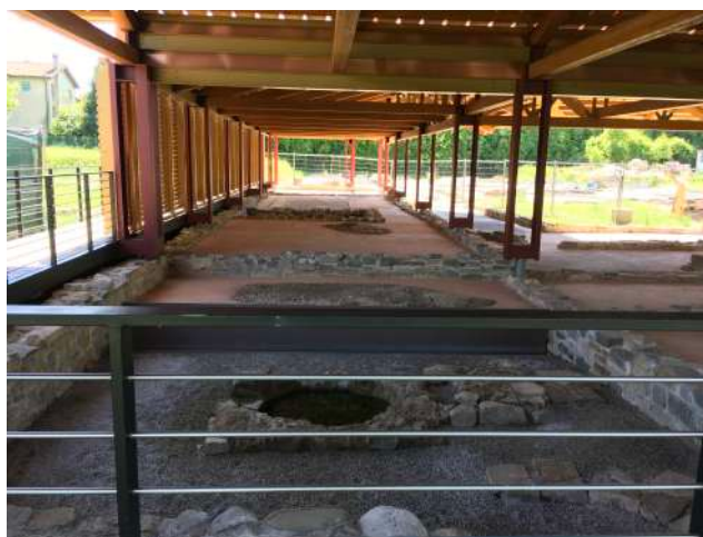
Fig.9 Struttura di copertura.
