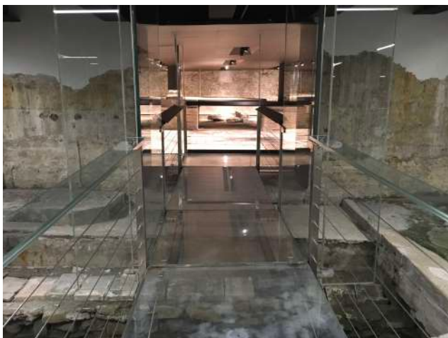
Fig.24 Parapetto della prima parte del percorso.
