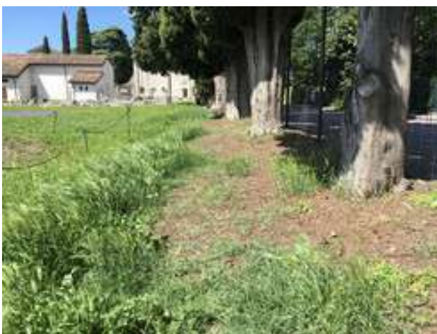
Fig.8 Percorso perimetrale in pendenza e con radici.
