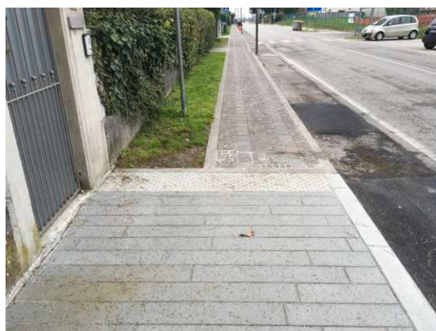
Fig.9 Marciapiede con segnale tattilo-plantare di pericolo assoluto.
