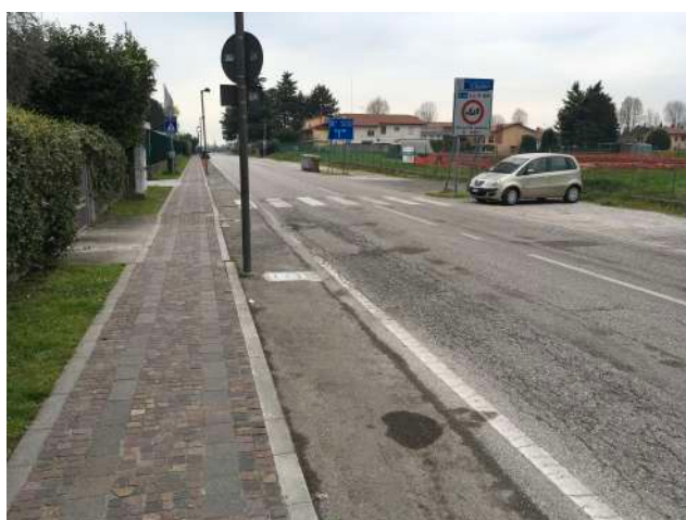
Fig.8 Marciapiede in porfido con scivoli.
