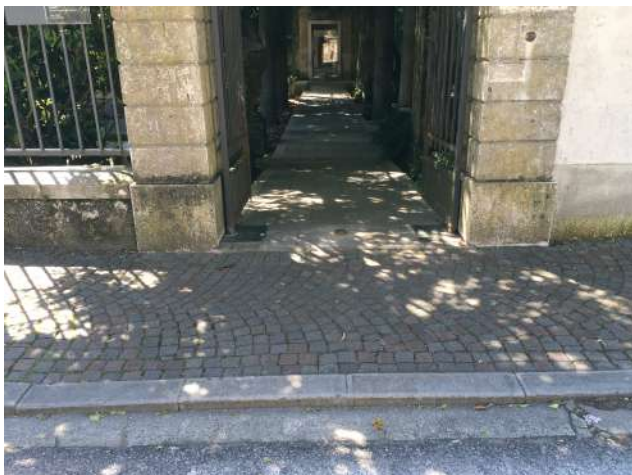
Fig.2 Marciapiede con scalino di 5 cm.
