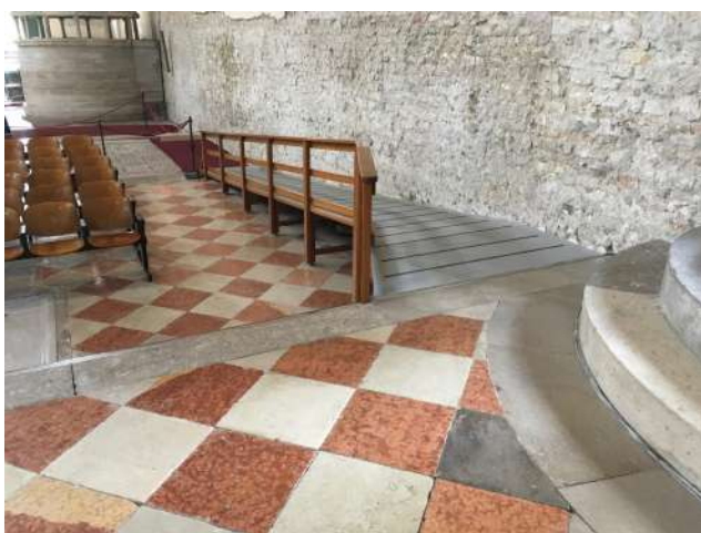
Fig.22 Rampa in legno con parapetto ad altezza 70 cm.
