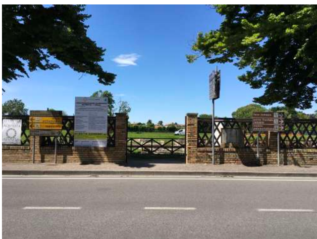
Fig.2 Vista esterna dell'ingresso principale.
