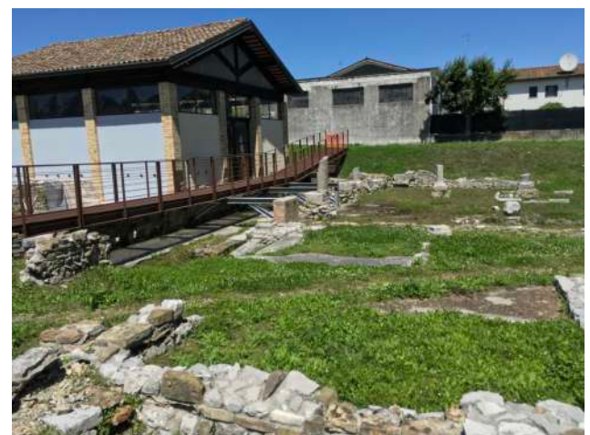
Fig.11 Tratto conclusivo della passerella metallica con pendenza elevata.
