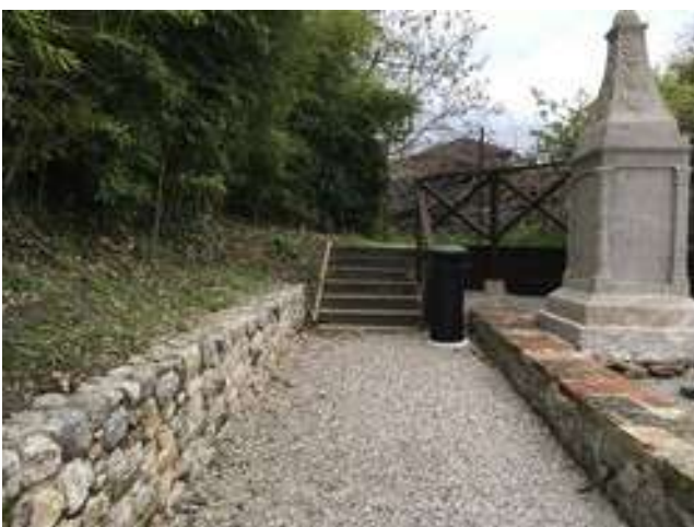
Fig.6 Scala in pietra di salita alla passerella.
