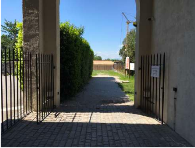
Fig.4 Vista esterna dell'ingresso Sud.
