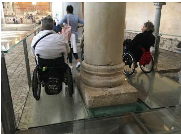
Fig.12 Passaggio di carrozzine su passerella in vetro.
