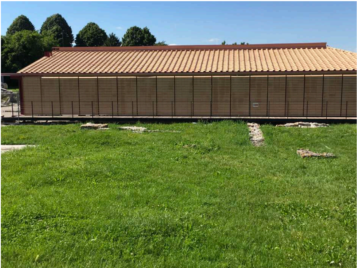
Fig.1 Vista della nuova struttura di copertura del Fondo Cossar
