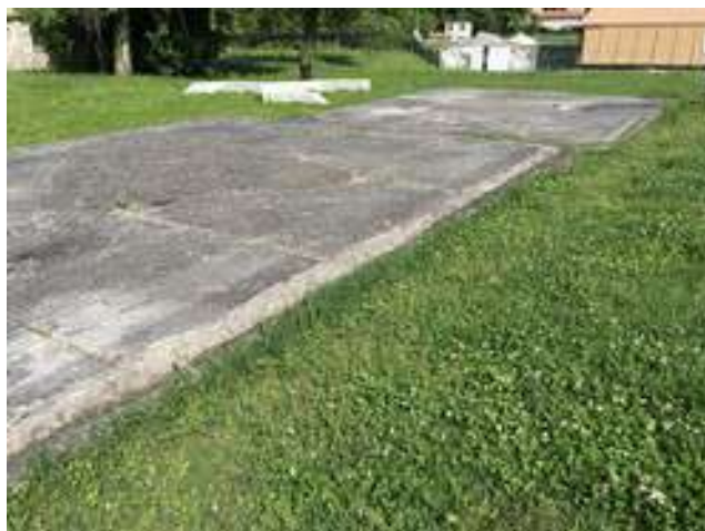
Fig.12 Platee di cemento con mosaici degradati dagli agenti atmosferici.
