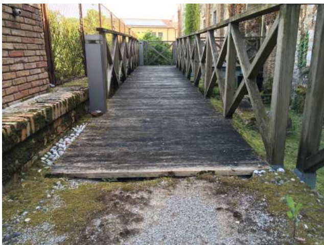
Fig.6 Passerella in legno dell'ingresso secondario.
