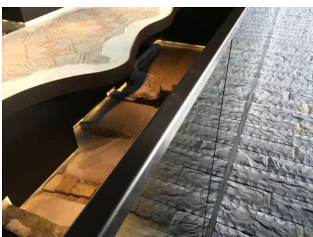
Fig.9 Parapetto in vetro con profili cromati arrotondati.
