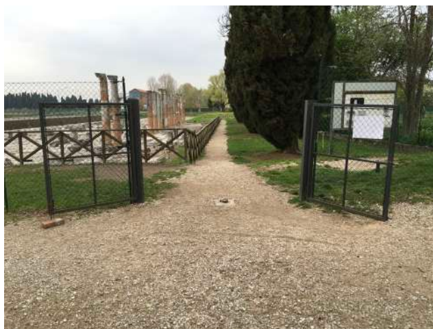
Fig.7 Cancellone d'ingresso del Foro.
