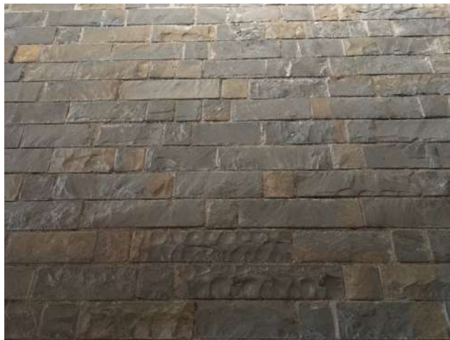
Fig.11 Pavimentazione della Südhalle
