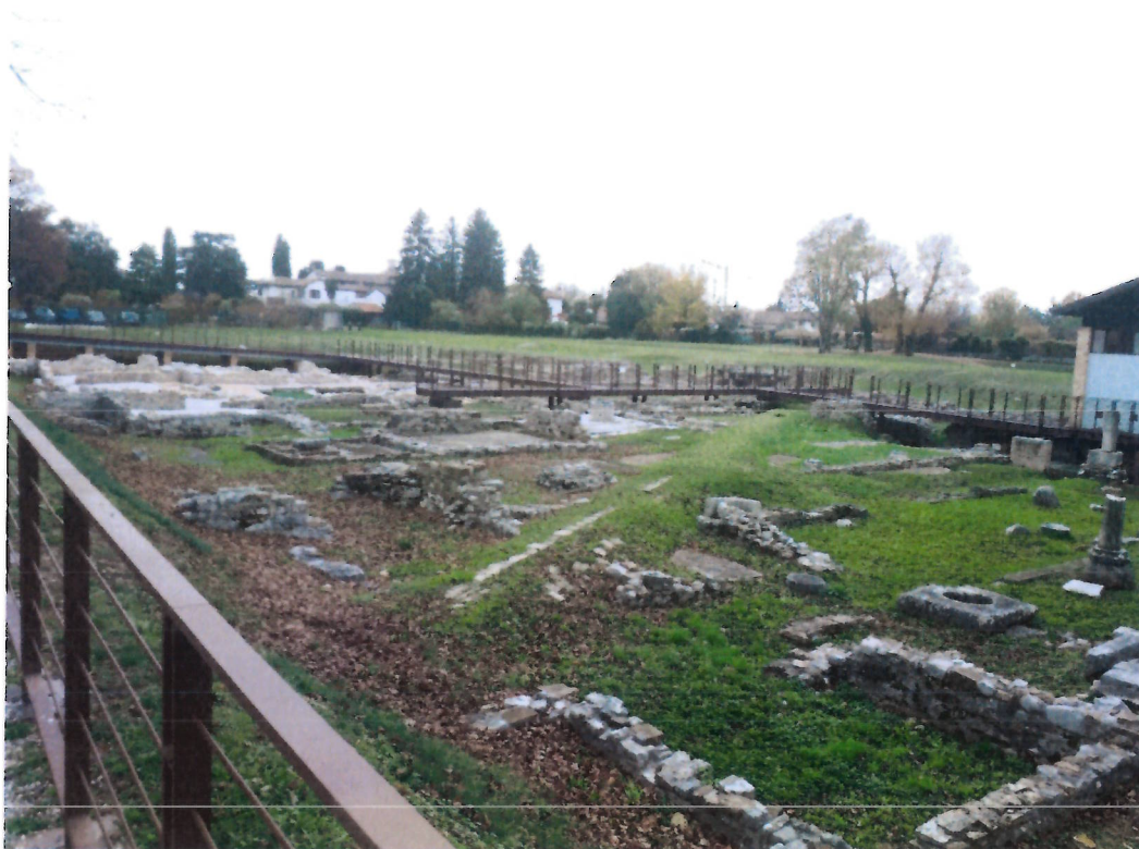
Punto di presa 4
